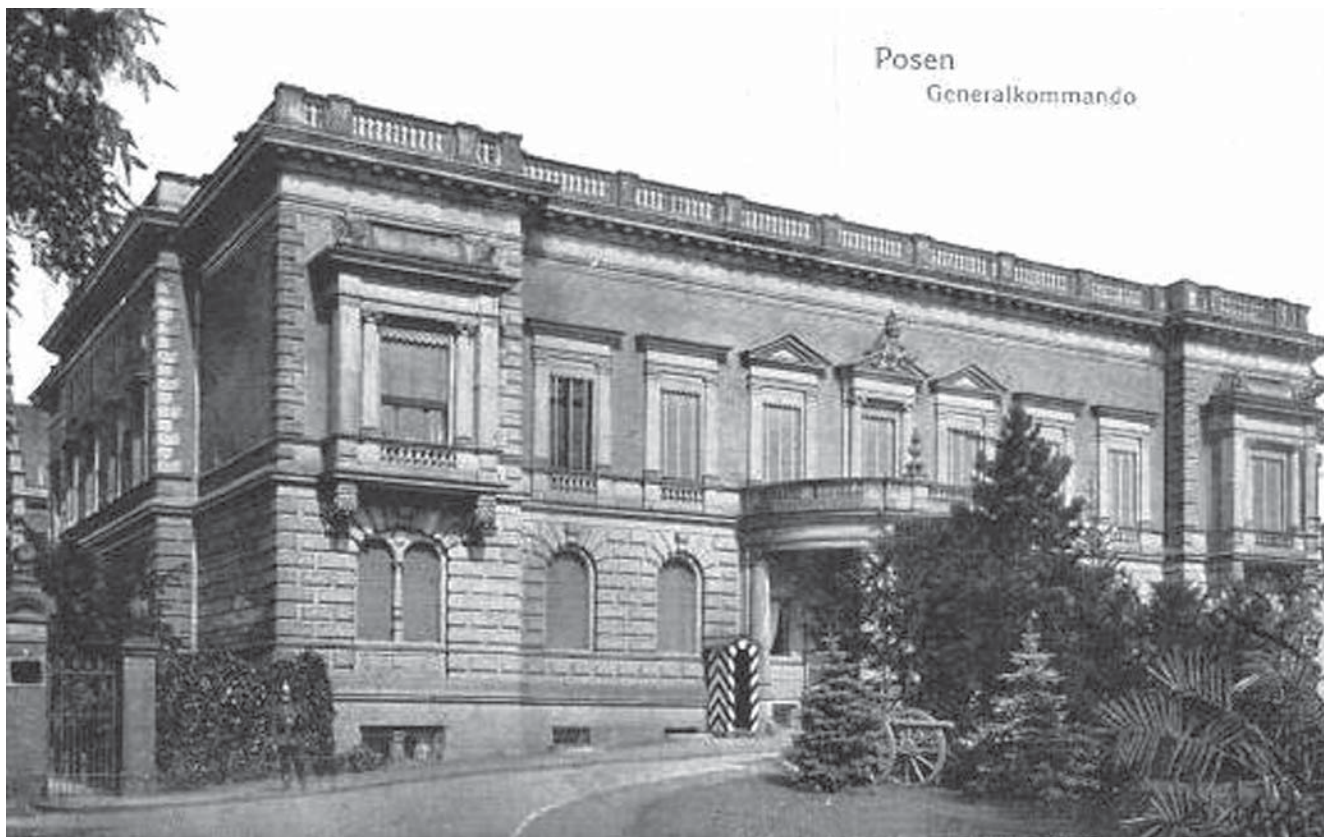
Rycina 2. Budynek Dowództwa V Korpusu Armijnego (Kanonnenplatz - obecnie ul. Solna).
