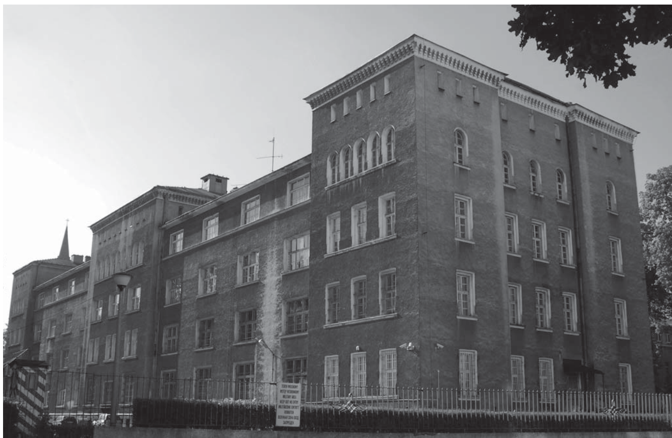
Rycina 2. Współczesny widok Szpitala Zapasowego nr 1 (DWLot, ul. Libelta).
